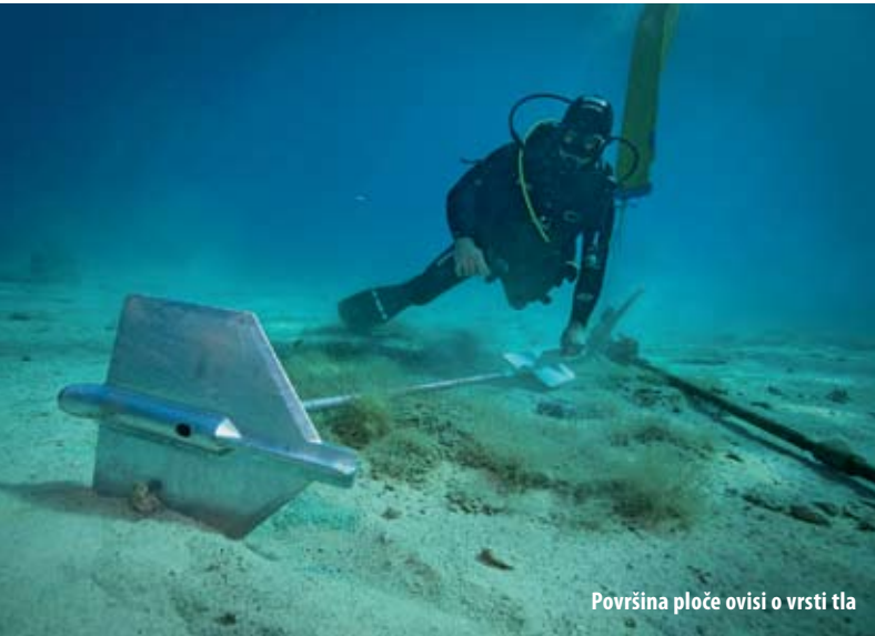
Kad se ploča pneumatskim čekićem zabije do kraja, dlijeto se izvuče natrag
